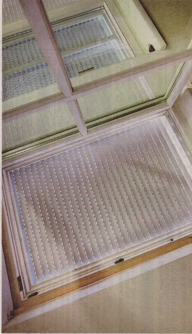
Rollläden verdunkeln den Raum nicht nur, sie wirken vor dem Fenster auch wie eine zusätzliche Dämmschicht. FOTO: DIAGENTUR/DPA
